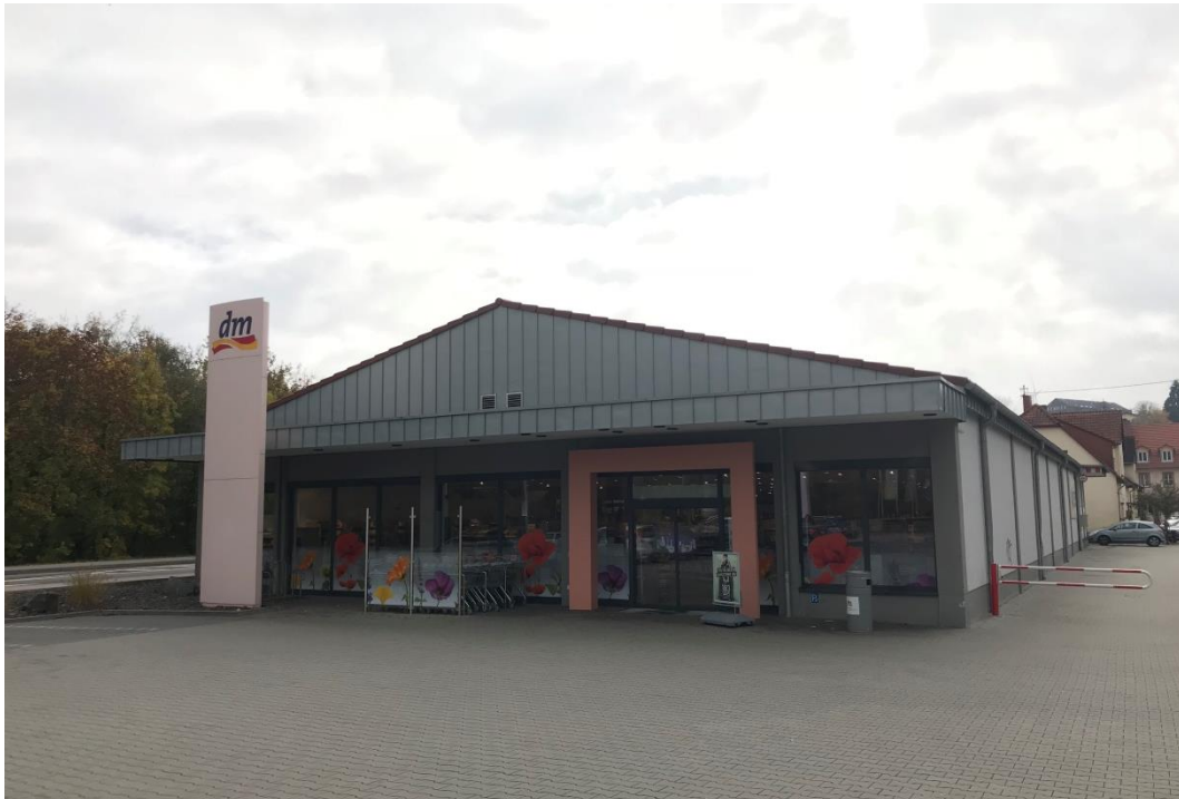
Abbildung 13: dm-Drogeriemarkt, Bliessstraße – ZVB Ottweiler, Zone 1
