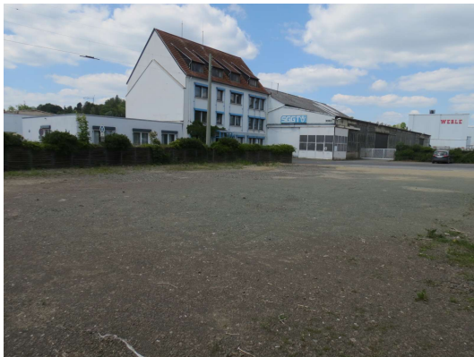
Abbildung 3: Schotterfläche entlang der Gleisanlagen
