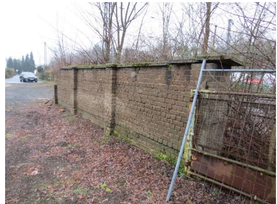
Abbildung 4: Steinmauer mit teilweise offenen Fugen im Bereich der ungenutzten Schotterfläche
