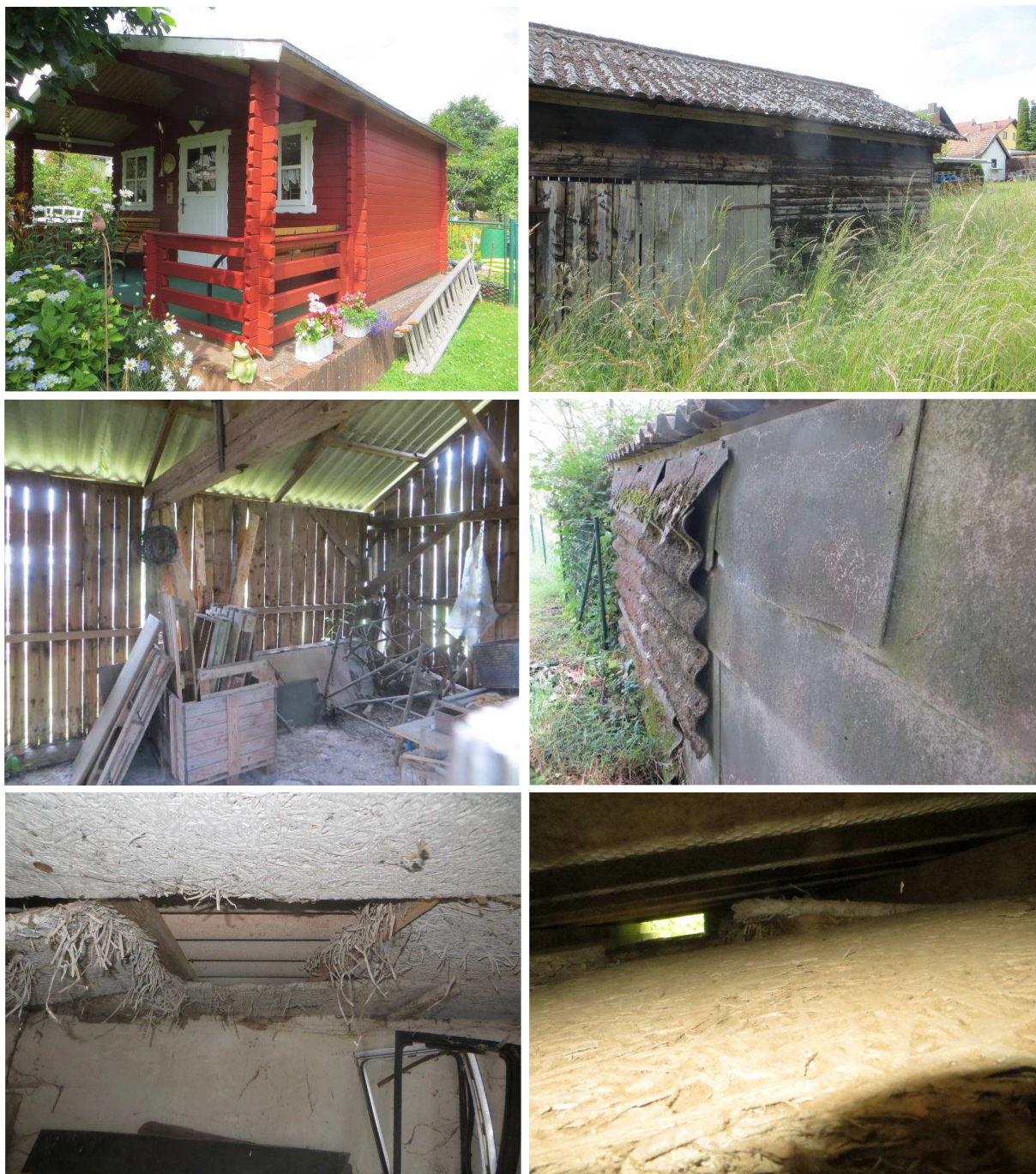
Abb. 9: mögliche Quartiere am Gebäudebestand, o.l. die Gartenlaube mit Toilettenhäuschen in Fertigbauweise besitzt keine erkennbaren Quartierpotenziale; o.r. und Mitte links: die Feldscheune ist aufgrund der sehr lückigen Bretterwände zu hell und weist weder außen noch innen geeignete Ritzen und Spalten auf; der ehemalige Hühnerstall bietet noch das beste Potenzial: Außenverkleidung mit Eternitplatten (M.r.), Abhängung der Dachkonstruktion mit Grobfaserplatten (untere Bildreihe)
