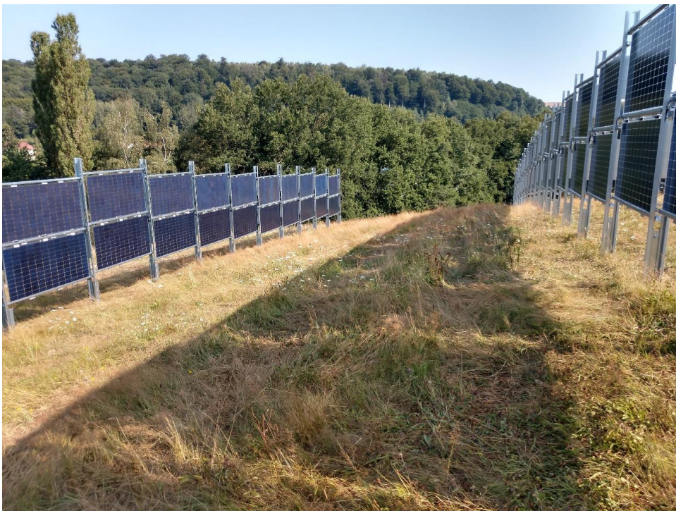
Foto 1: Anlage der Next2Sun GmbH in Dirmingen (Quelle: IFÖNA GmbH)
