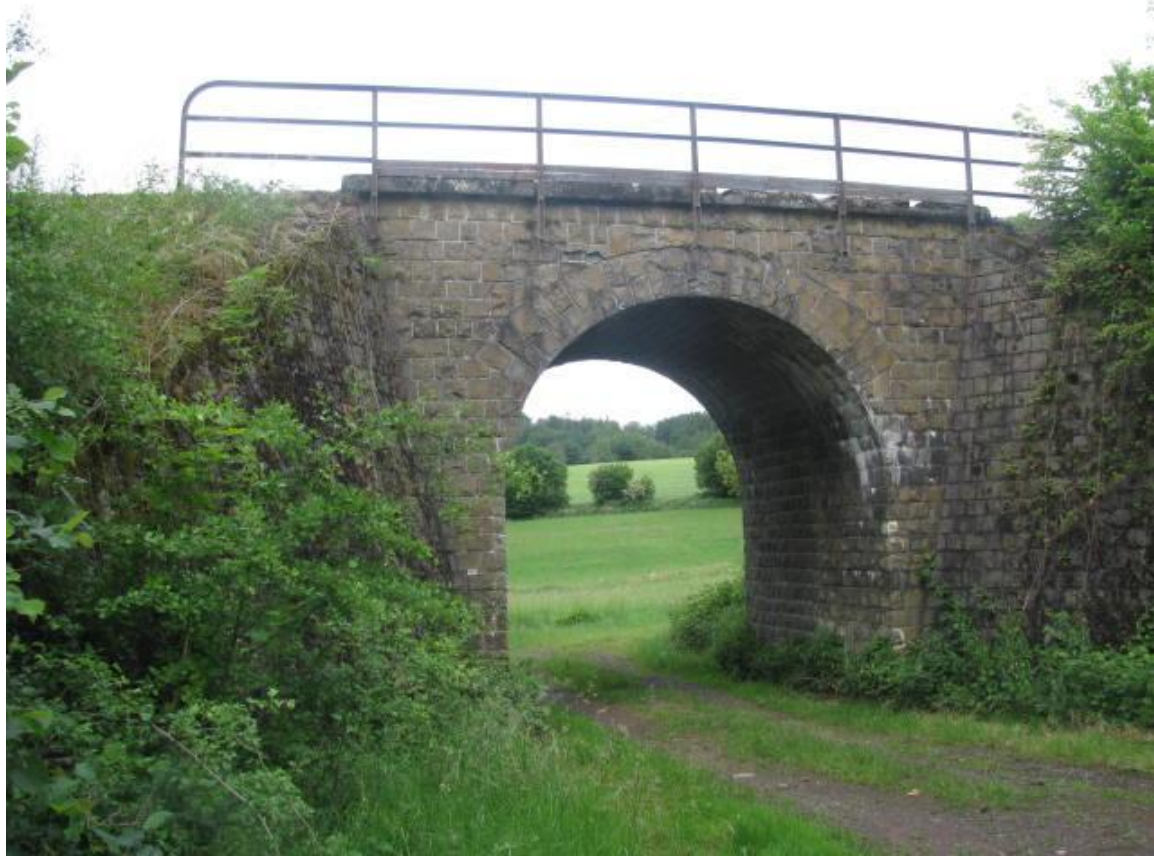
Abbildung 3: Bahnlinie der Ostertalbahn
