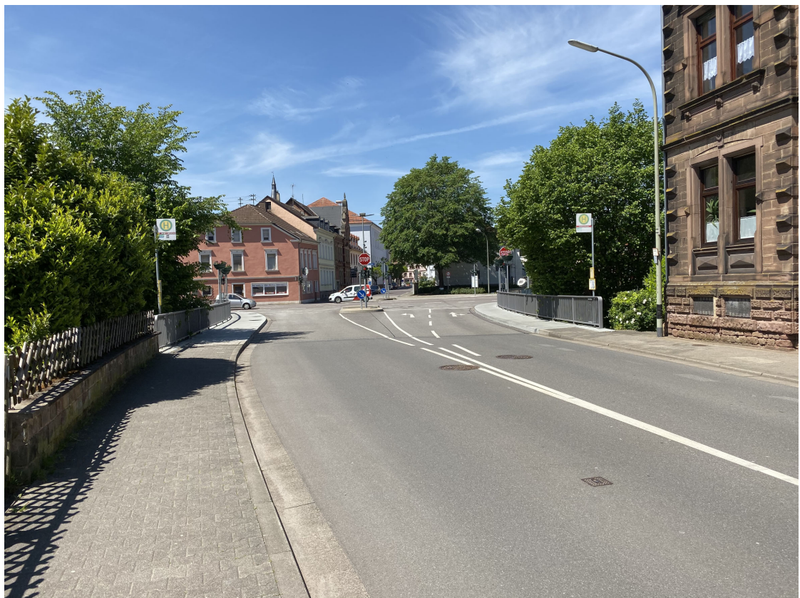
Abb. 4: Knotenpunkt B41 Bliesstraße / Schloßstraße aus Richtung Bahnhof mit „St. Remy-Brücke“
