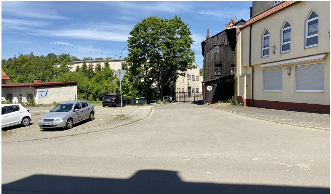
Abb. 6: Zufahrt ehemalige Firma „SGGT“ und geplantes „Blieszentrum Ottweiler“
