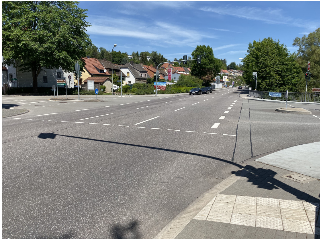
Abb. 3: Knotenpunkt B41 Bliesstraße / Schloßstraße in Fahrtrichtung St. Wendel
