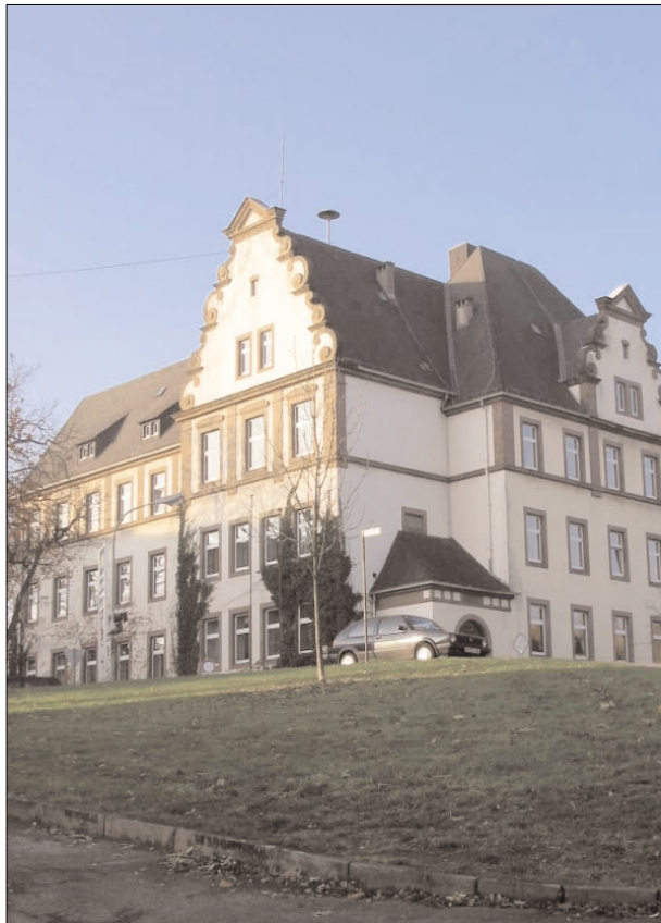
DENKMALGESCHÜTZTES AMTSGERICHT OTTWEILER
