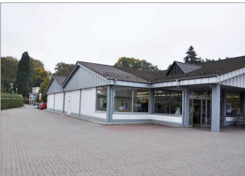
Erweiterungsbereich an der nördlichen Gebäudeseite; Foto: Kernplan
