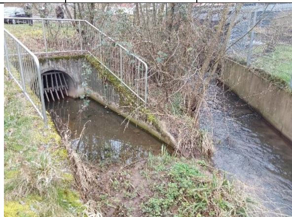
Abbildung 4-12: Einlaufsituation in den Lauten- bach Höhe Breitwieser Straße
