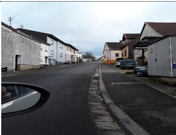
Abbildung 4-31: Fließweg entlang des Betzelbacher Wegs Höhe Hofstraße
