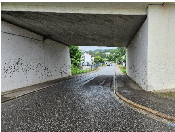
Abbildung 4-39: Fließweg entlang der Unterführung der Straße Im Neuweiher
